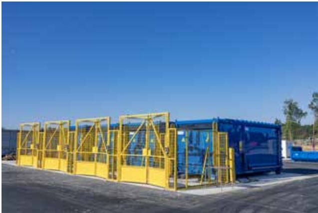
Compacteurs de la déchetterie de Pontault-Combault
