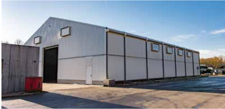
Quai de transfert
