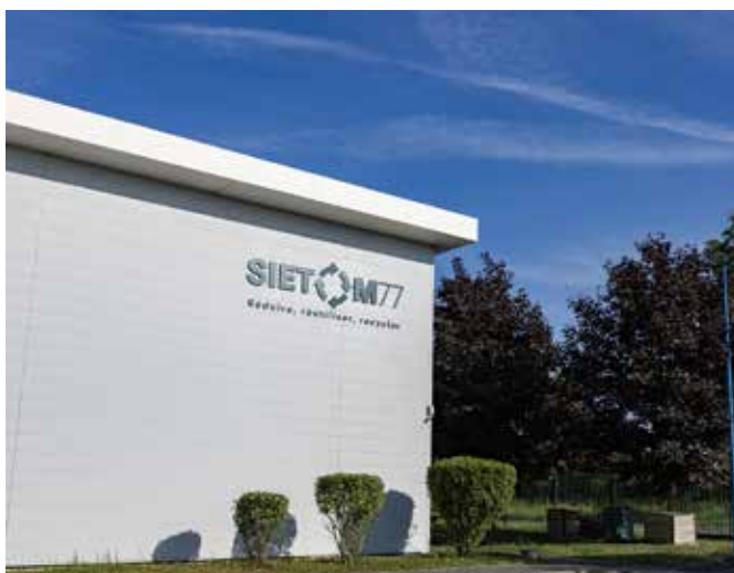
Enseigne côté parking
