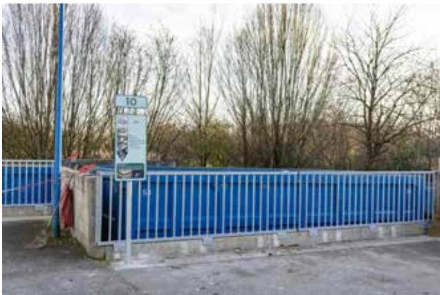
Nouveaux gardes-corps sur toutes les déchetteries
